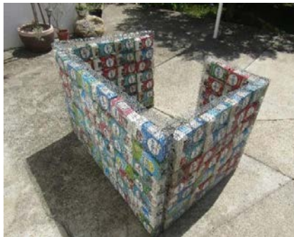
Fig. no. 4. Paneles estructurales construidos a la medida de las paredes requeridas para la casa del perro.
